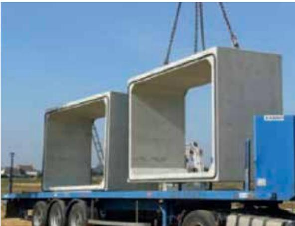
La sécurité des opérations de manutention est assurée au moyen de chaînes à 2 ou 4 brins, mises à disposition par Chapsol
