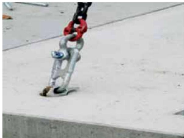
Ces chaînes viennent se fixer aux éléments préfabriqués à l'aide d'anneaux et d'ancres de levage intégrées à la fabrication.
